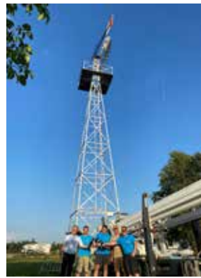
Sanierung des Windrades Foto: Gem. Edt/L.
