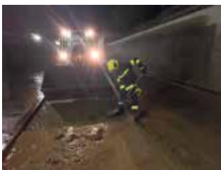
Reinigungsarbeiten der überfluteten Eisenbahnunterführung in Aichham nach einem Starkregenfall Foto: Edt-Winkling
